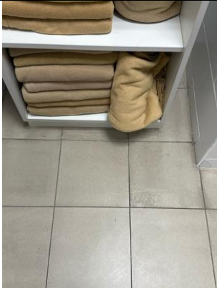
Bodega con piso sucio, Cuarto A.
